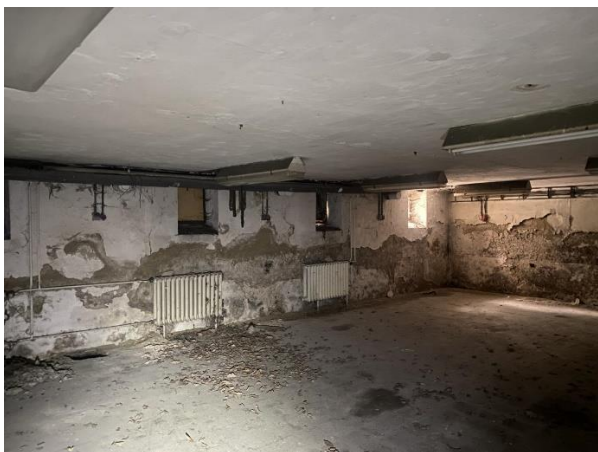
V části 1.PP směřované do ulice Wolkerova jsou svislé konstrukce podstatně vlhčí a plochy degradovaných omítek větší. Zasaženy jsou i na středovém zdivu celoplošně po strop.
