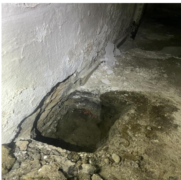
V provedených sondách v podlaze části do ulice Wolkerova se objevuje hladina spodní vody.
