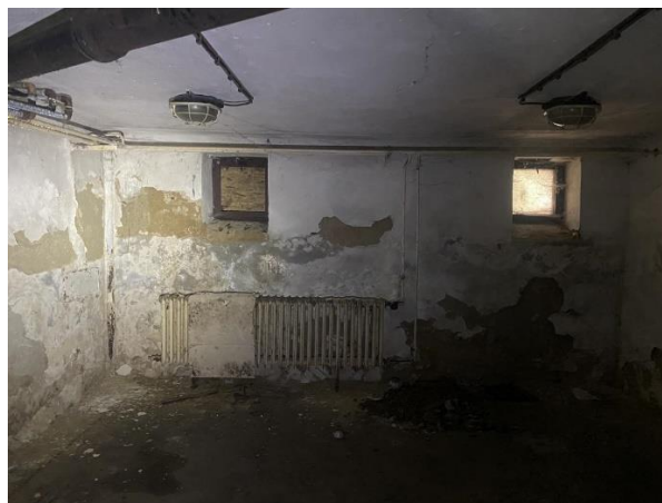
V části 1.PP směřované do ulice Wolkerova jsou svislé konstrukce podstatně vlhčí a plochy degradovaných omítek větší. Zasaženy jsou i na středovém zdivu celoplošně po strop.
