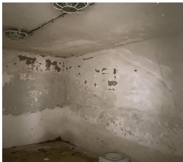
Obvodové konstrukce 1.PP této části jsou pod úrovní terénu namáhány zemní vlhkostí z rubu z terénu, ale i povrchovou vodou vlivem zatékání do konstrukce.
